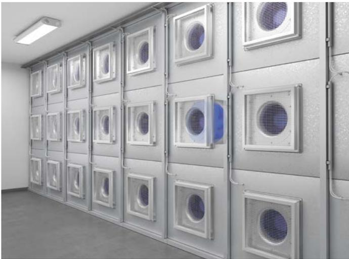
Se instalaron 27 ventiladores radiales con motores EC en una construcción de pared con una formación de varios ventiladores.
